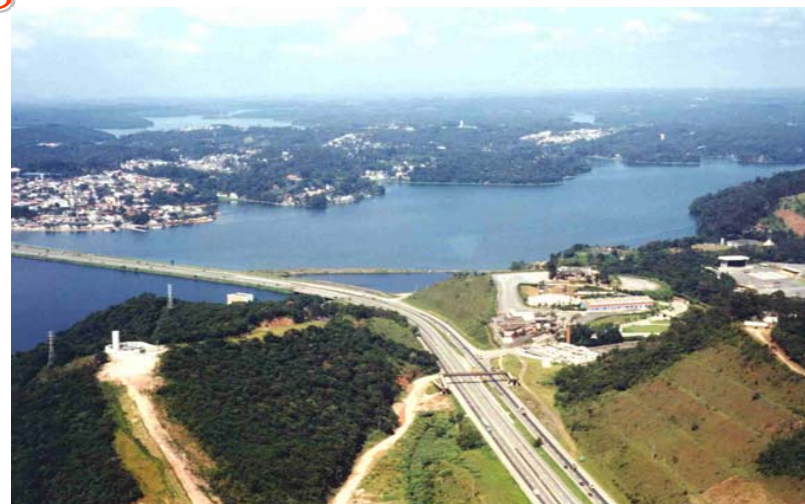
Captação de água
